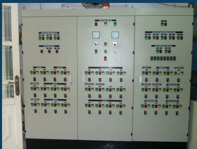
Tủ điều khiển PLC
